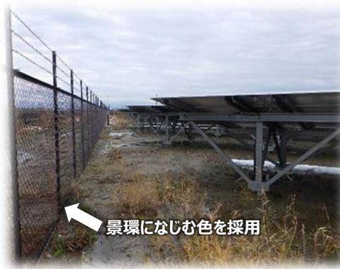
太陽光発電パネルからの近隣住宅等への反射光を低減するよう、発電所の設計段階で考慮
