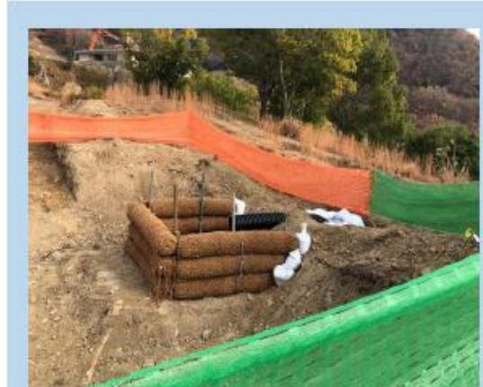
沈砂池とバイオフィルターの設置
